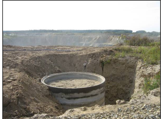
Abbildung 30: Erweiterung des Systems durch einen Sandfilter (hier im Baustadium)
