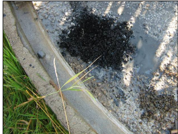
Abbildung 33: Substrat des Sandfilters - weiße Ablagerungen (Oberste Schicht), schwarze Ablagerungen (darunterliegende Schicht) (August 2013)
