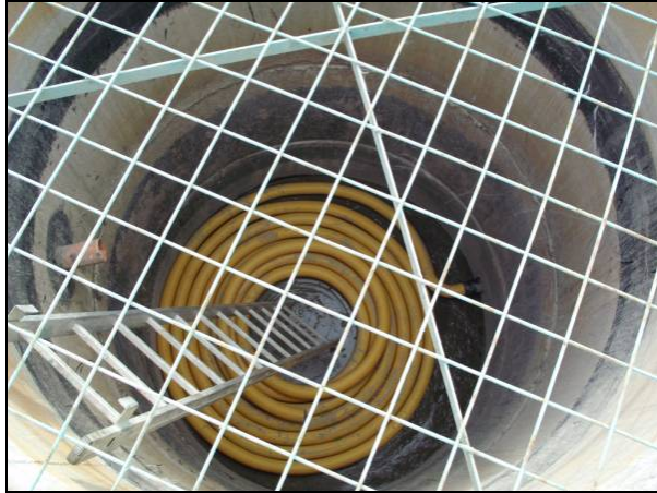
Abbildung 29: Erweiterung der Drainage in den beräumten Reaktoren
