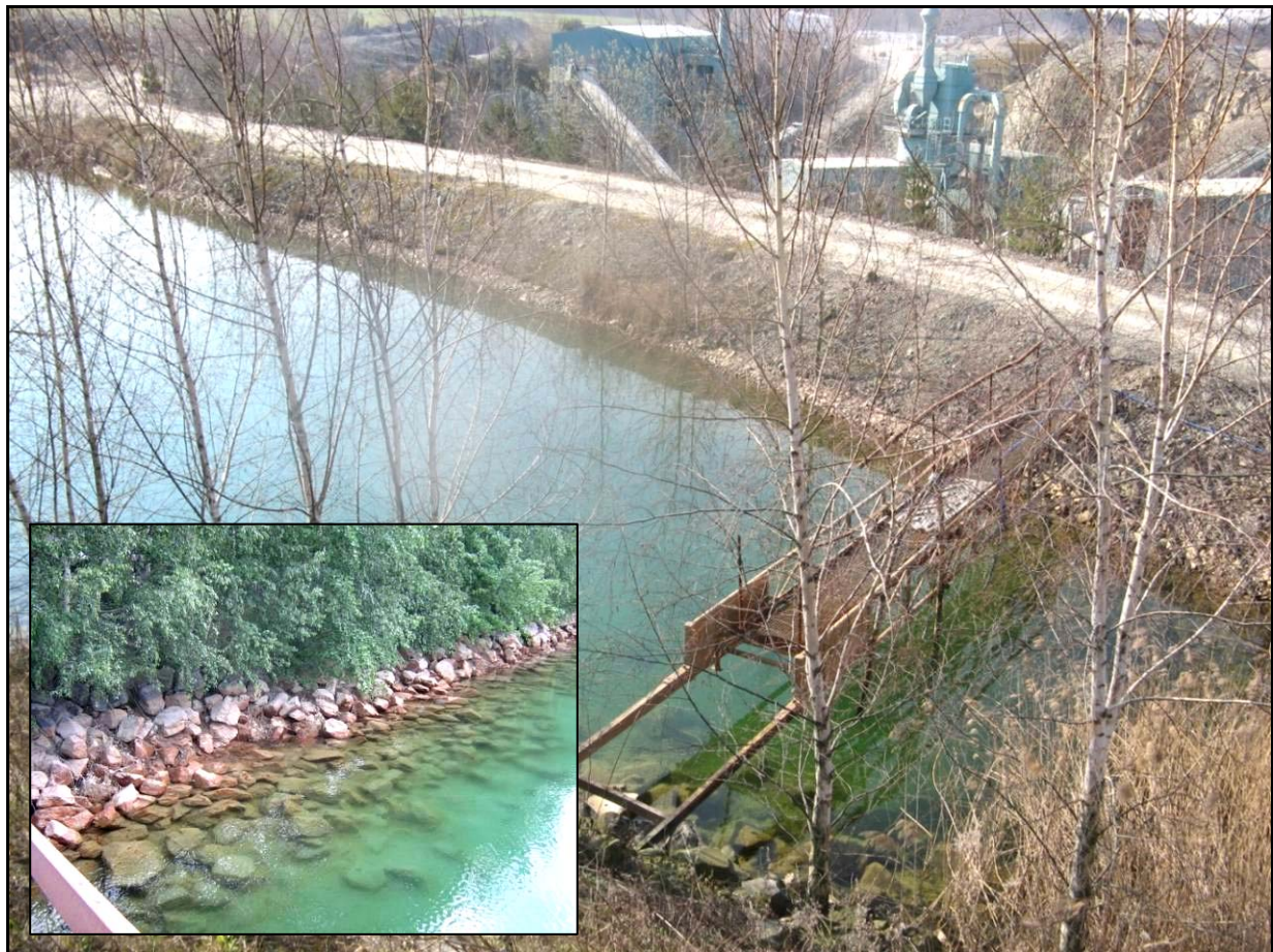
Abbildung 4: Erstes Absetzbecken mit leicht rötlichen Eisenausfällungen - von hier aus Abpumpen des Wassers zur Pilotanlage (20.03.2012)
