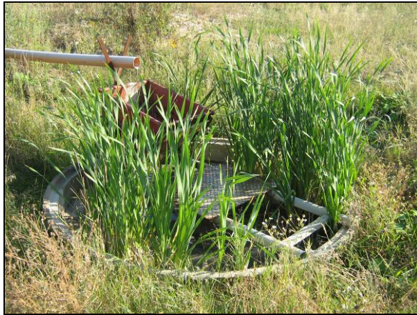
Abbildung 32: Mit Schilf bepflanzter Sandfilter inklusive Kippvorrichtung (August 2013)
