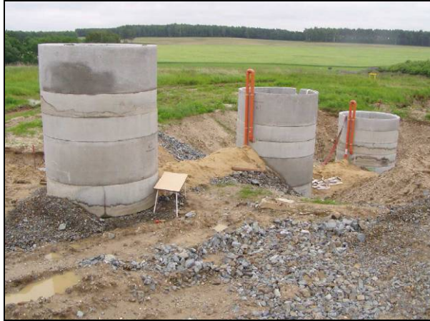
Abbildung 27: Bau der Pilotanlage (I) auf dem Steinbruchgelände (Behälter je 20 \text{ m}^3 )
